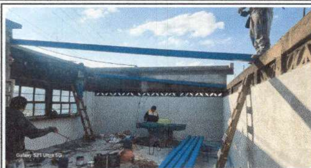
Foto 1: Sustitución de lámina por lámina troquelada y estructura de soporte de madera por metal en cocina
