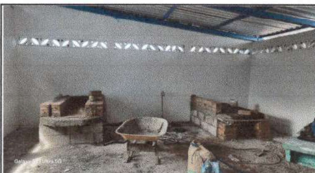
Foto 4: Sustitución de estufa rural (Completa) incluye chimenea y plancha de metal en cocina
