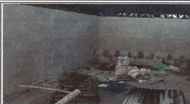
Foto 2: Repello en muro en cocina
