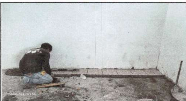
Foto 3: Sustitución de piso de torta de concreto por cerámico en cocina
