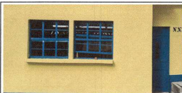
Foto 5: Sustitución de Ventanas y puerta en cocina
